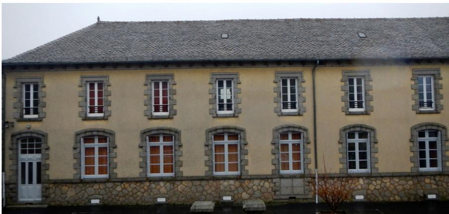
Dans le but d'harmoniser l'ensemble de ces bâtiments, toujours sur les recommandations de M. Jouilé, six fenêtres du rez-de-chaussée de l'école primaire ont été remplacées par des fenêtres bois et l'ensemble des huisseries repeintes en gris clair.
